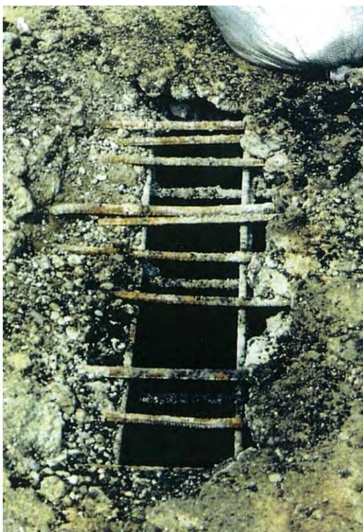
床版コンクリートの抜け落ち、陥没が発生している。<sup>5)</sup>
