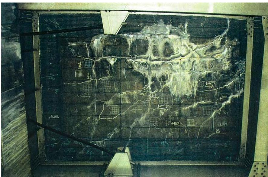
床版コンクリートに亀甲状のクラック、漏水および遊離石灰が発生している。<sup>5)</sup>
