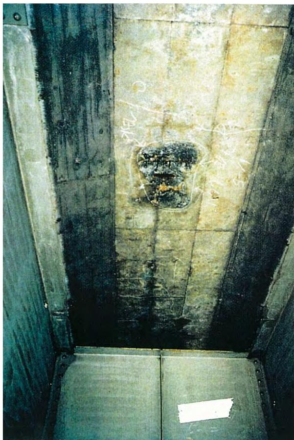
床版支間中央のコンクリートが剥落し、主鉄筋および配力筋の一部が露出している。<sup>5)</sup>
