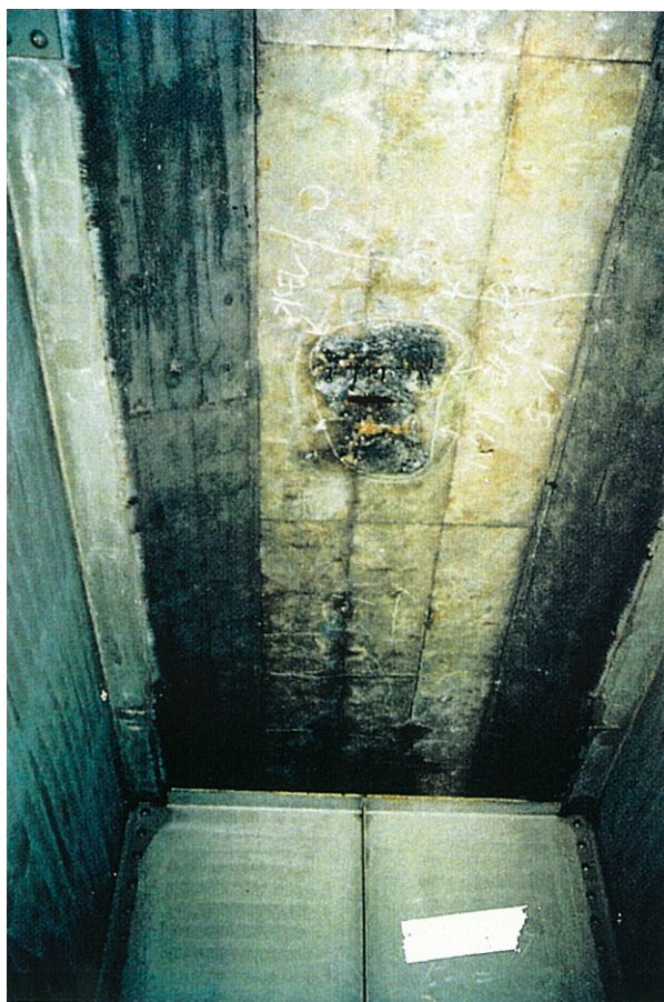
床版支間中央のコンクリートが剥落し、主鉄筋および配力筋の一部が露出している。 5)
