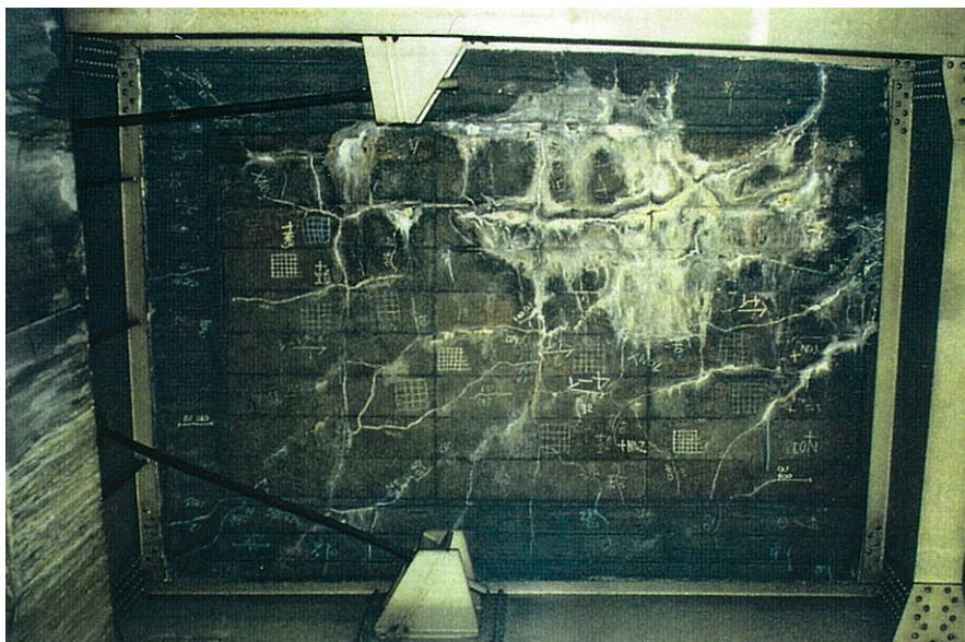
床版コンクリートに亀甲状のクラック、漏水および遊離石灰が発生している。 5)
