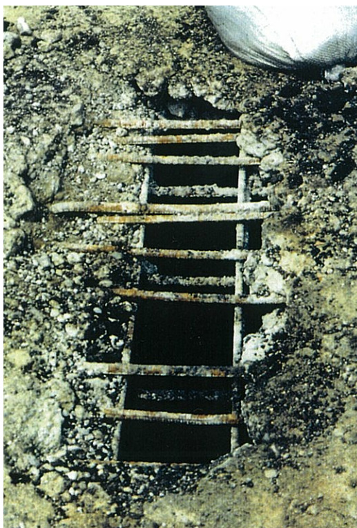
床版コンクリートの抜け落ち、陥没が発生している。 5)
