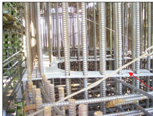
図 2-3-21 テンプレート設置状況写真
