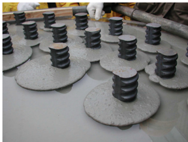
図 2-3-18 下フランジ側供試体のコンクリートフローの状況
