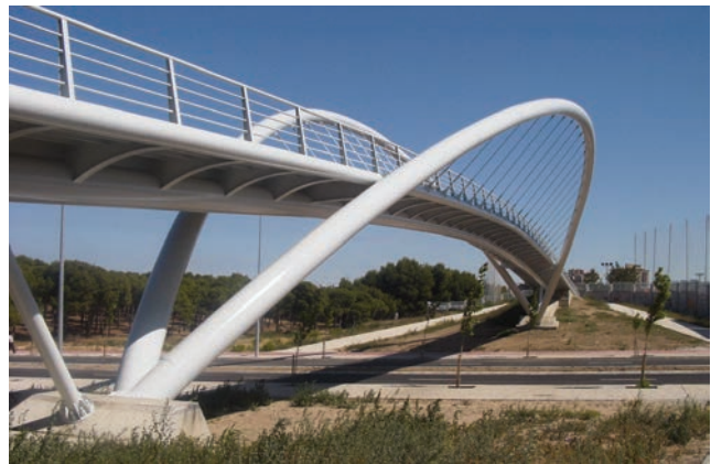
Footbridge across the 'Ronda de la Hispanidad'（スペイン、2002年） 3)
