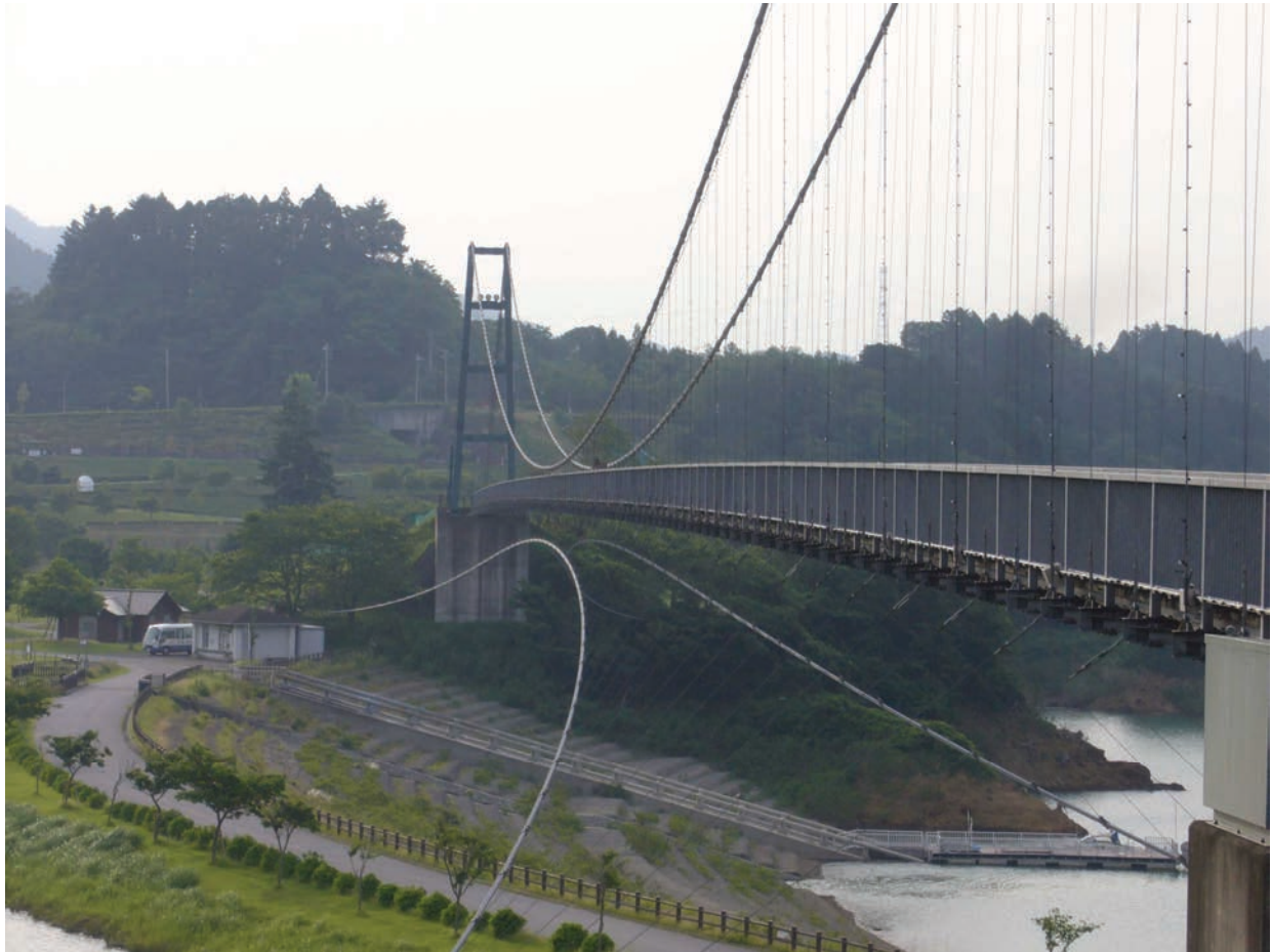
図 4-4 対象橋梁の全景
