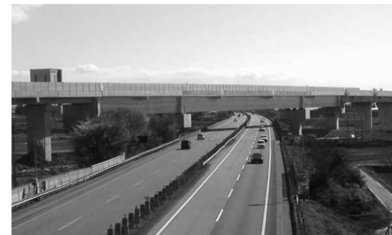
北陸新幹線浅生架道橋
