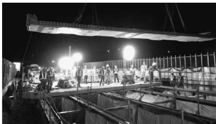
厳しい条件下で行われている床版架替え工事
