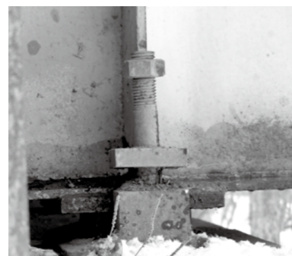
支承アンカーボルトの抜け出し
