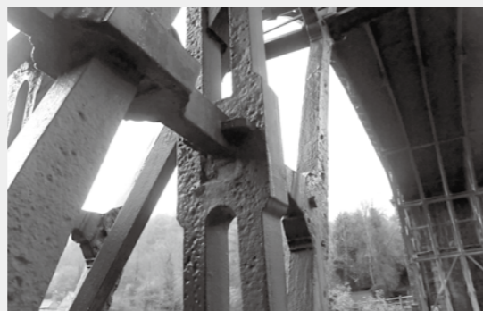
粗い肌を見せる左岸側支点附近の鋳鉄部材
