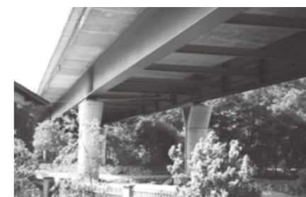
フランス、オピタル橋（広幅員2主桁橋）
