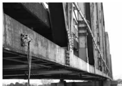
新しい領域の未知なるもの、ロボティック点検・計測
