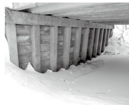
コンクリート組み立て式橋台
