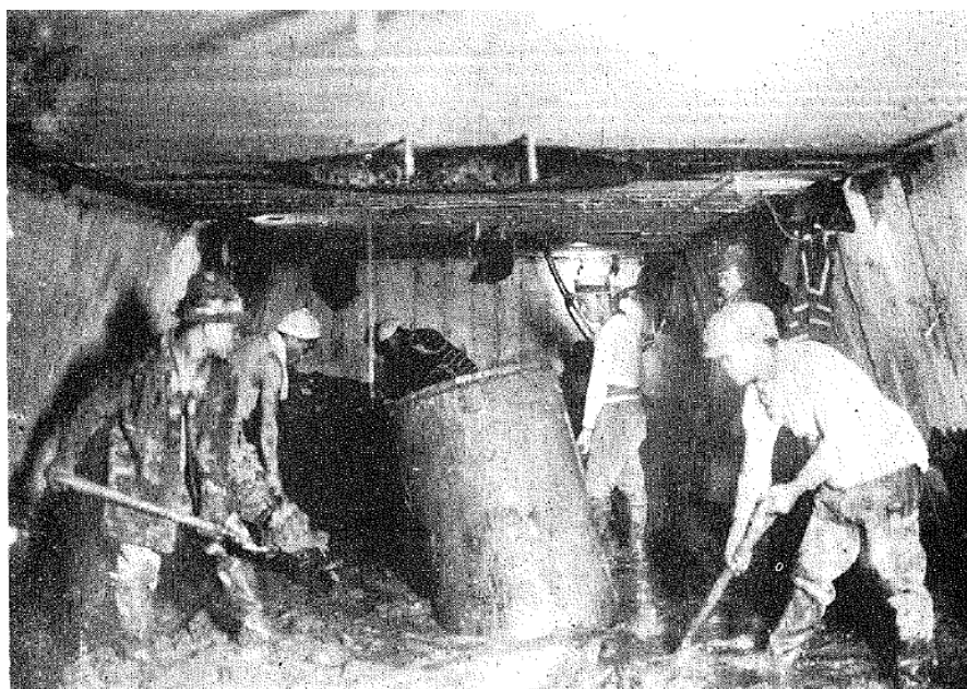
図-27 ケーソン内作業状況
