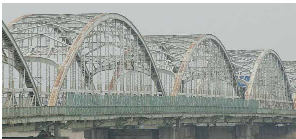
写真-5 落下物防止柵設置
