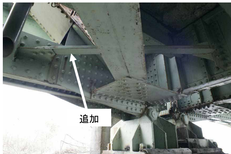
写真-4 耐震補強
