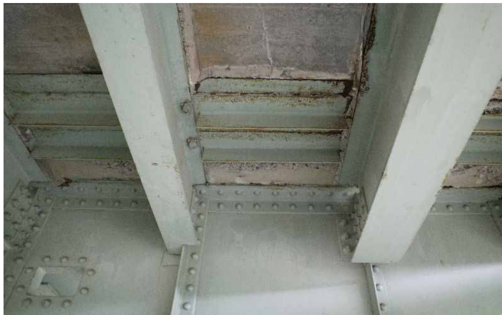
写真-3 床版補強
