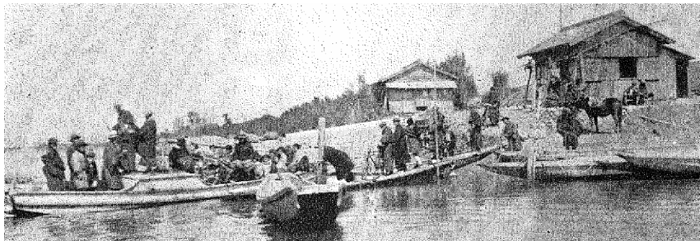
図-1 架橋前の渡船の状況
