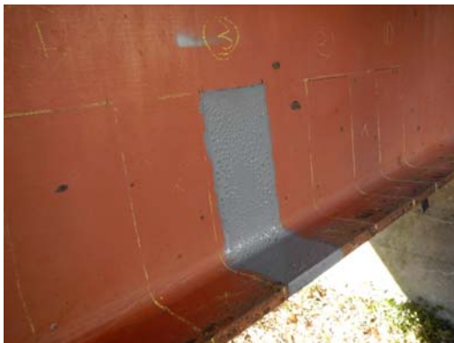
図 4-8 吹付け後の状態
