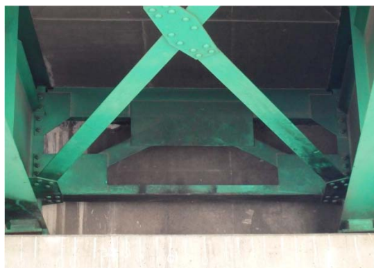
b) 対傾構構造
