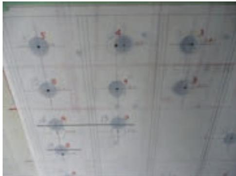
図 2-2-6 削孔位置の計測
