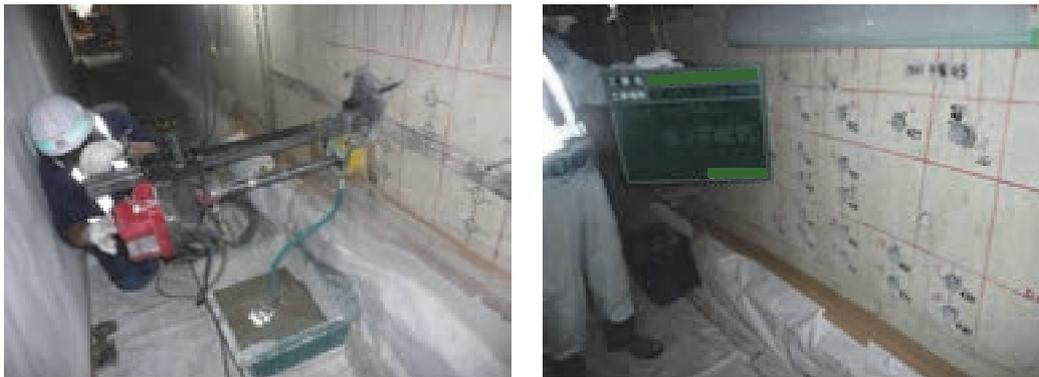
図 2-2-5 コンクリート削孔
