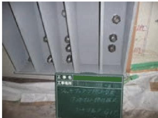
図 2-2-8 鋼製ブラケット設置
