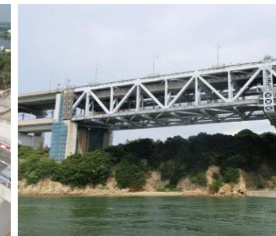
樅石島高架橋(トラス部)の耐震補強(香川県)
