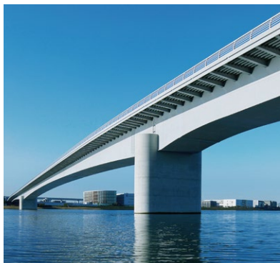
多摩川スカイブリッジ (東京都・神奈川県)
