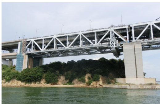
榎石島高架橋 [トラス部] の耐震補強 (香川県)
