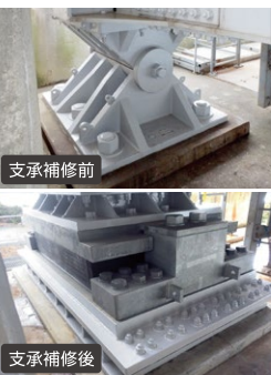
支承補修前 支承補修後
