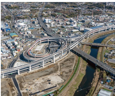
横浜港北JCT高架橋 (神奈川県) 写真提供: 首都高速道路株式会社
