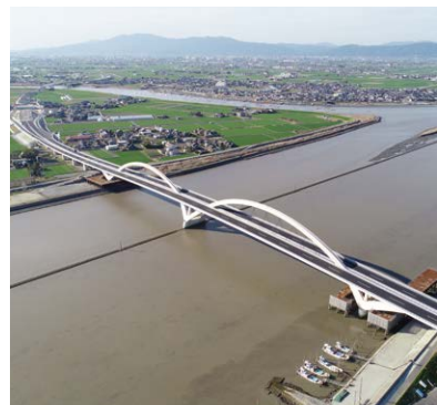
有明筑後川大橋(福岡県) 写真提供: 国土交通省九州地方整備局
