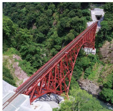
南阿蘇鉄道第一白川橋梁(熊本県)
